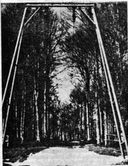
L'impianto di risalita di «Le Rotte» in Pian Cansiglio.
